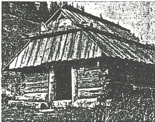
Hala Stoly w Tatrach Zachodnich. Zabytkowy szalas pasterski. Jednoprętrowy, wysoko- ucowy, pokryty dranicami wzmocnionymi systemem czołowo połączonych ram — na wzór jarzem (dachu jarzmowej). Waskofrontowy. (Fot. Marian Matusiak)
